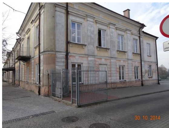
Fot. 4. Widok ogólny ściany bocznej budynku narożnego. .
