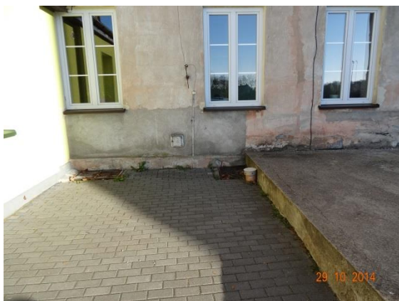
Fot. 25. Ściana tylna budynku. Zawilgocenia dolnych fragmentów ściany. Tynk częściowo wymieniony.
