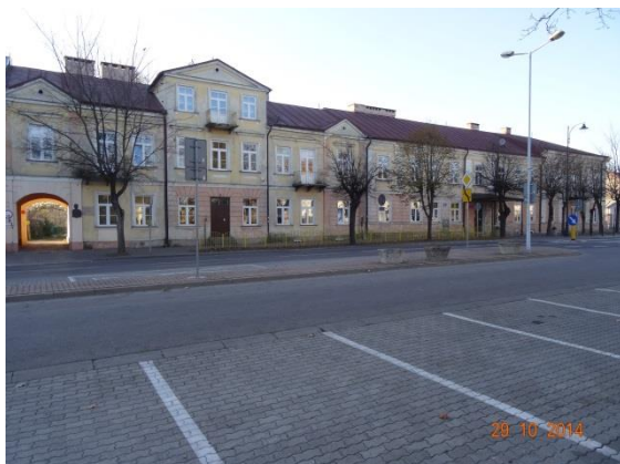
Fot. 1. Widok ogólny elewacji frontowych budynków wchodzących w skład kompleksu Szkoły Podstawowej nr 9 w Suwałkach.
