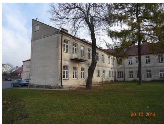
Fot. 6. Widok ogólny ściany szczytowej i elewacji frontowej oficyny.
