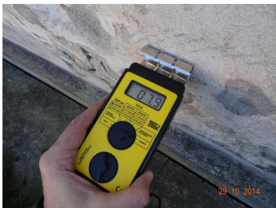
Fot. 33. Pomiar wilgotności muru między otworami górnego rzędu iniekcji – pomierzona wartość minimalna.
