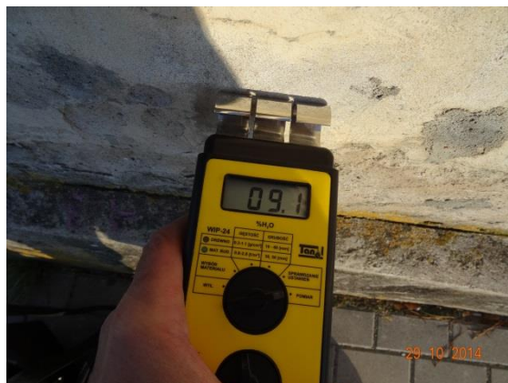
Fot. 36. Pomiar wilgotności muru między otworami górnego rzędu iniekcji.
