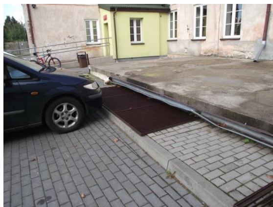
Fot. 51. Zrealizowany sposób odwodnienia dachu nad dawniejszym składem opału.
