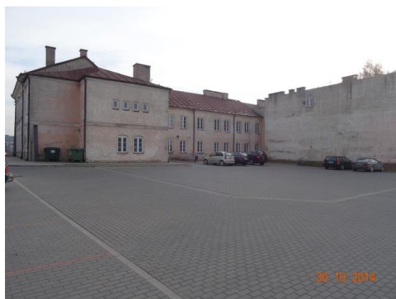
Fot. 5. Widok elewacji tylnej – fragment od ściany szczytowej do oficyny.
