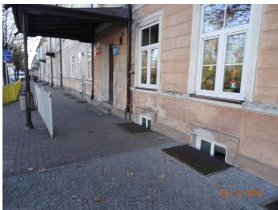
Fot. 8 i 9. Przykładowe zawilgocenia i uszkodzenia tynku w dolnej części ściany frontowej
