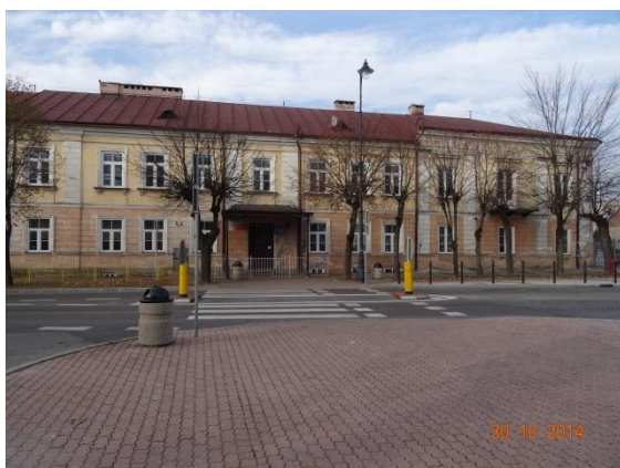
Fot. 3. Elewacje frontowe. Budynek główny szkoły i część frontowa budynku narożnego
