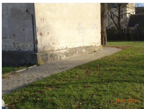
Fot. 35. ściana szczytowa oficyny. Przy lewym narożu widoczne kilka otworów iniekcyjnych umieszczonych w dwóch rzędach.
