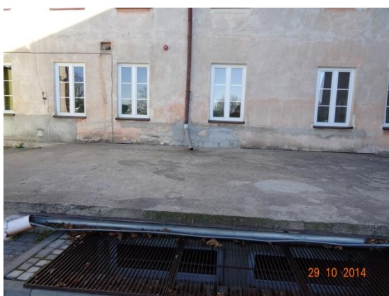
Fot. 25. Ściana tylna budynku. Zawilgocenia dolnych fragmentów ściany. Tynk częściowo wymieniony.
