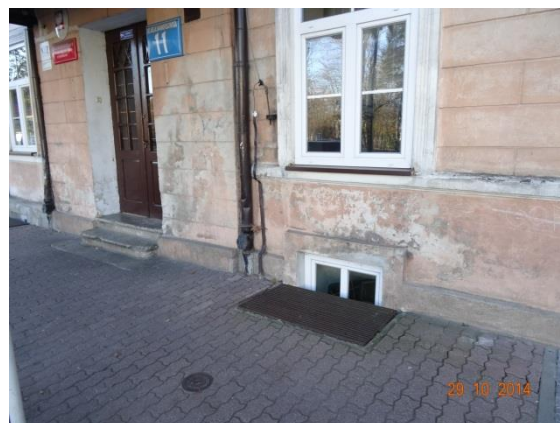
Fot. 10. Zawilgocenia ściany frontowej przy wejściu do budynku.
