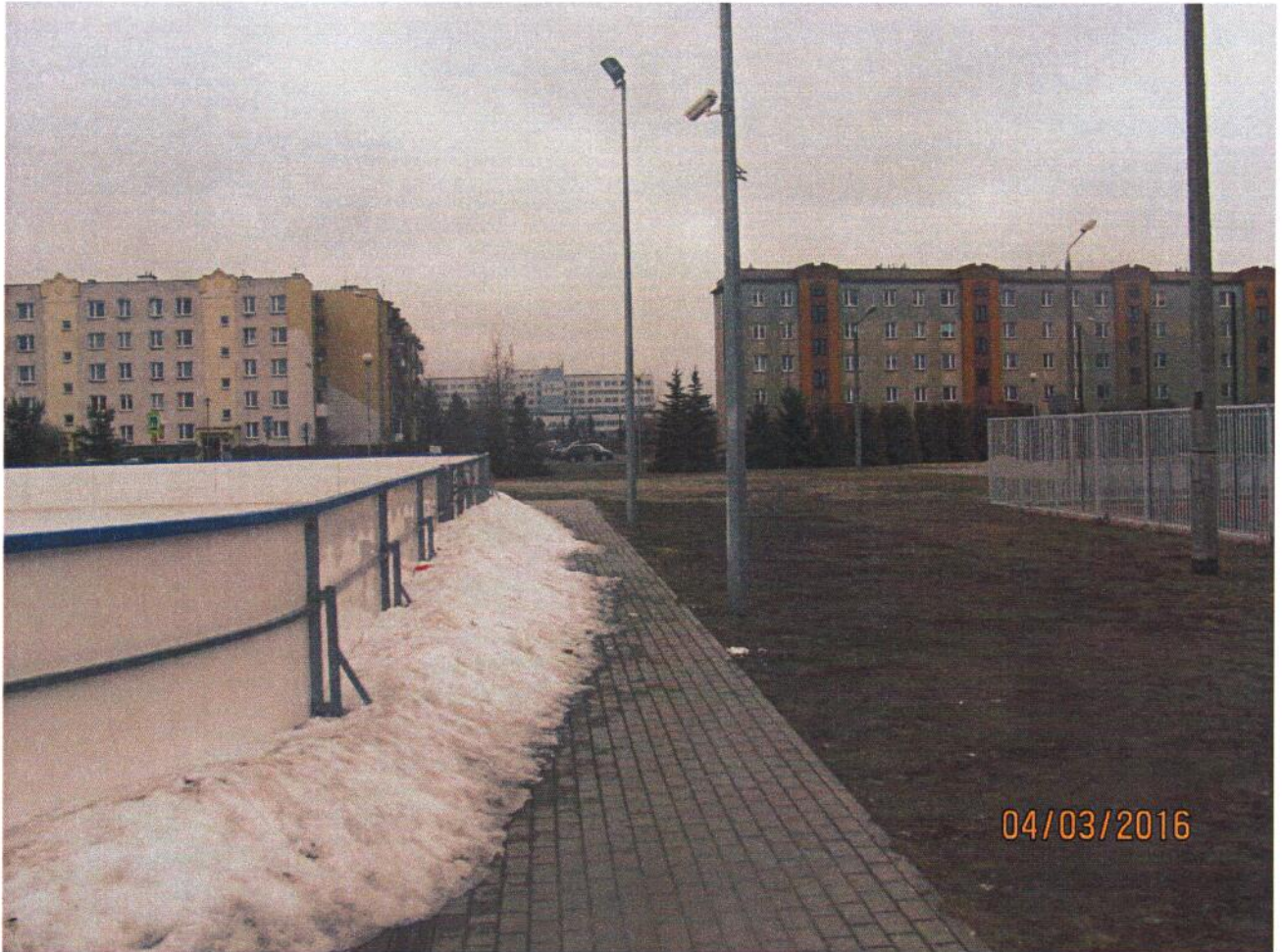
Fot. Nr 3 widok od strony zachodniej / od strony szkoły/ z lataniami 2 szt do demontażu
