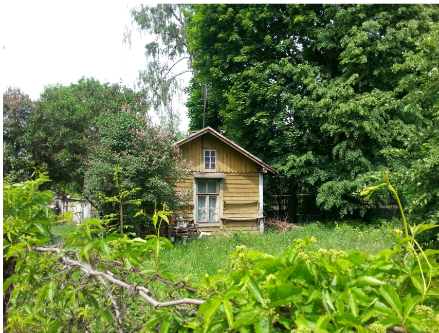
Budynek nr 2 (budynek mieszkalny)
