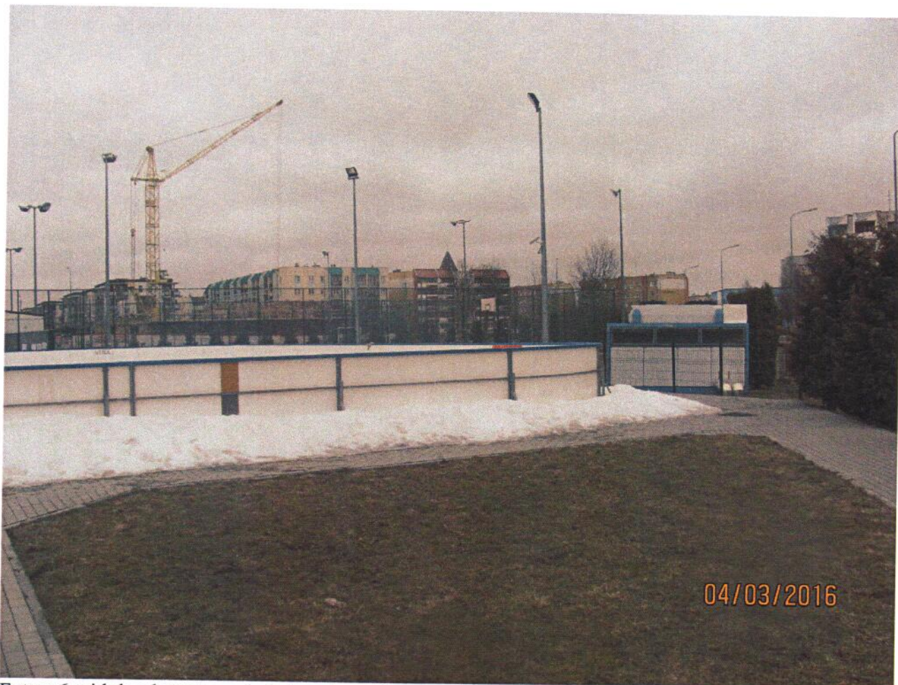
Fot nr 6 widok od strony południowej z widocznymi 2 szt. latarni oświetleniowych do demontażu od strony wschodniej
