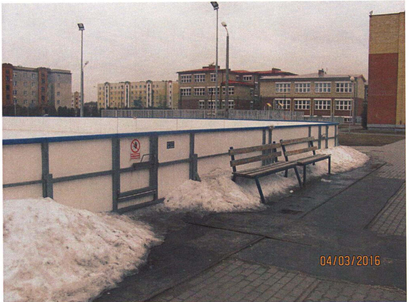
Fot nr 2 widok od strony północnej /od strony boiska do koszykówki/ z widoczną bramą wejściową w bandach.
